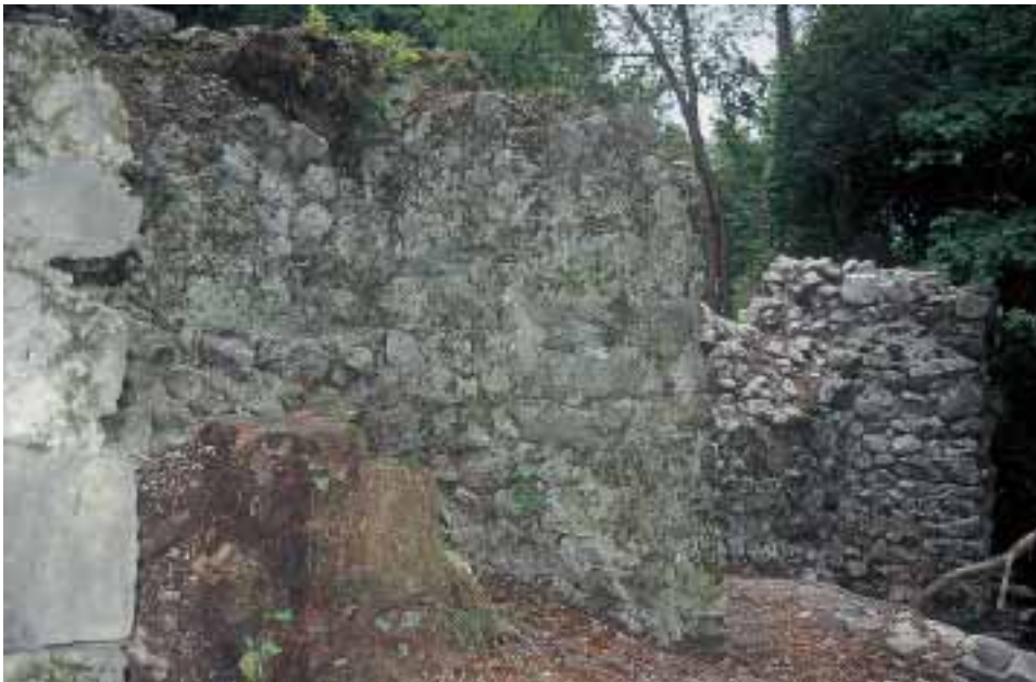
Fig. 2 - Settore A: veduta parziale da SW della facciata esterna del muro NE dell'edificio, munita di contrafforti.
