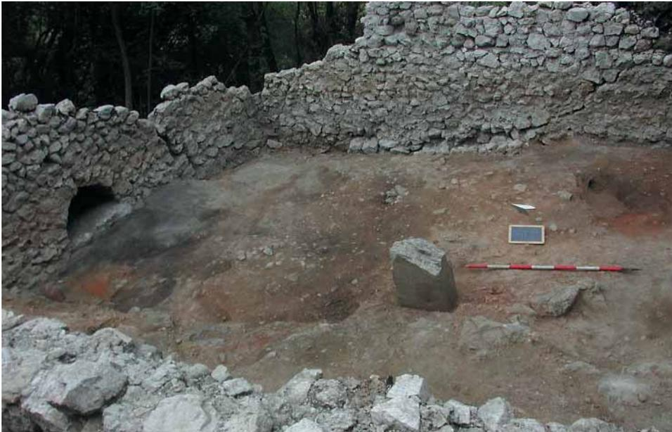
Fig. 4 - Settore A, Edificio I: nelle murature perimetrali fra loro ortogonali, in corrispondenza dell'angolo nord è evidente la presenza di due lesioni inclinate, poste in corrispondenza della trincea di fondazione dei muri.
