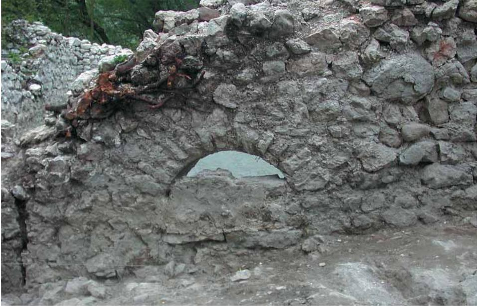
Fig. 16 - Settore A, Edificio II: tamponatura dell'apertura ad arco nel perimetrale SE.
