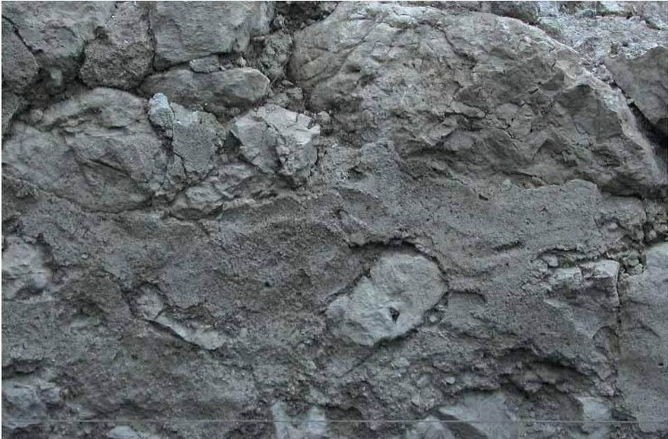
Fig. 26 - Settore B: intonaco di finitura presente sulla faccia interna del muro NW del fabbricato.
