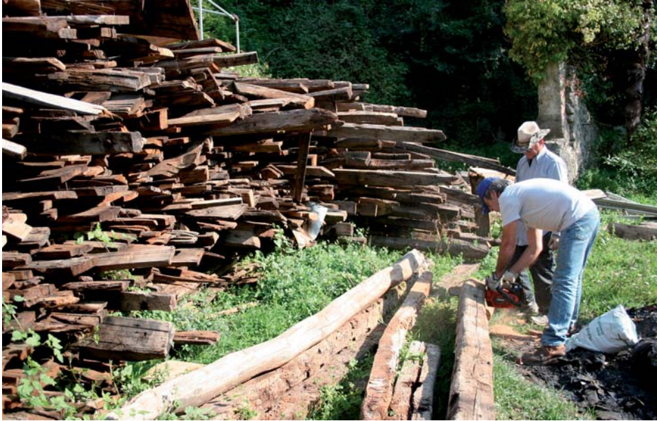
Fig. 2 - Prelievi dalle travi della chiesa pievana di Varese Ligure.
